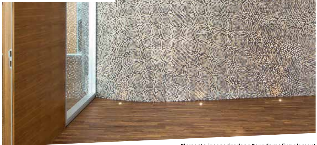
Elemento insonorizador / Soundproofing element integrado en el revestimiento de la pared, puerta cerrada integrated in wall panelling, closed door
