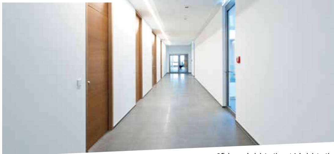
Oficinas administrativas / Administration Elemento insonorizador con panel superior Soundproofing element with top panel
